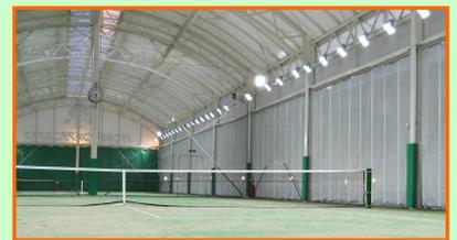
2010年3月、本製品のテストモデルとして導入された『LED照明 TCL110』（さいたま市のITC与野インドアテニスクラブ）当時は1コートあたり、約40個の照明器具を必要としていました。そして私たちは、より効率的な照射システムの研究を重ね、2011年12月、本製品を完成させました。『ハイパーステップLED』これが次世代のスタンダードモデルです。
