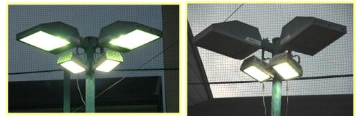
LEDの弱点といわれるグレア(眩しさ)を軽減する一方、光源にLEDのパネルに反射効率の良い素材と反射段差(ステップ)が、その理想の光の広がりと明るさを生み出しました。プレイヤーの声を最大限に取り入れ、LEDの利点をより高めた照明器が『ハイパーステップ』です。
